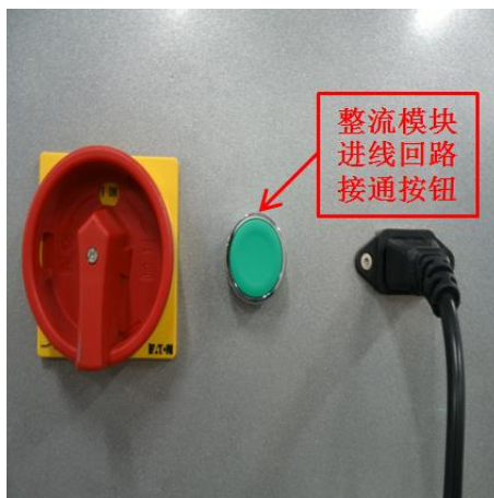
图 4-3 整流模块进线回路接通按钮
